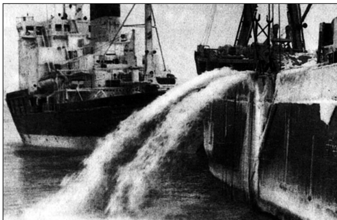
Теплоход «Коля Мяготин» на буксире у ледокола. Помпы, откачивающие воду из первого трюма работают на полную мощность. Восточно-Сибирское море, октябрь 1983 г.
