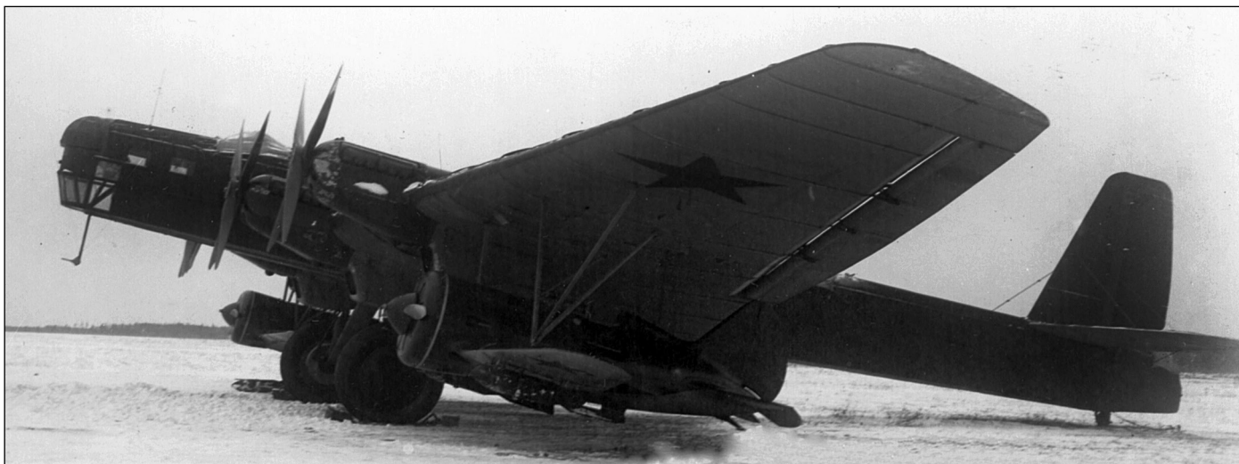
ТБ-3 4М-34РН + 2 И-16 М-25, определяемые как «Звено-СПБ» на аэродроме НИИ ВВС в ходе проведения совместных испытаний в декабре 1939 г.
