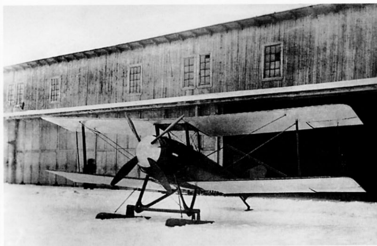
Вверху и внизу: МК-1 «Рыбка» установленный на лыжи зимой 1924 г.
