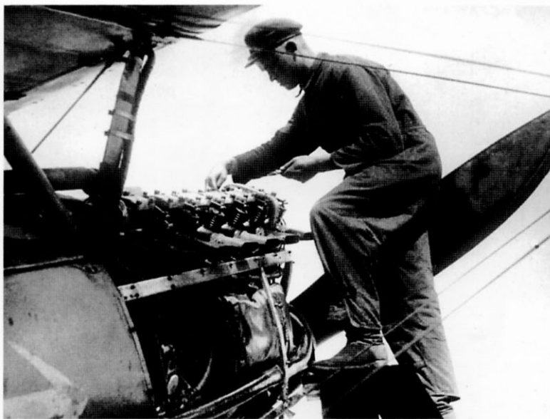
Регулировка двигателя М-17
