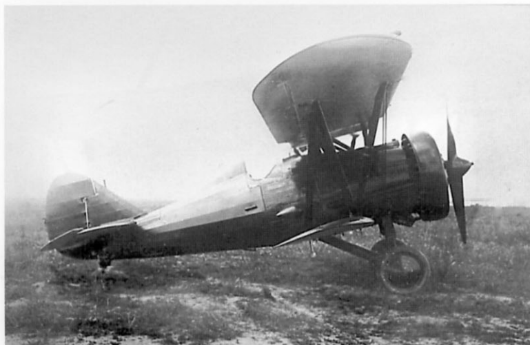
И-5 выпуска 1932 г. с деревянным воздушным винтом. Самолет построен на авиазаводе №21 по типу И-5 №4298 первого образца с новым капотом, оснащенным кольцом Тауненда
