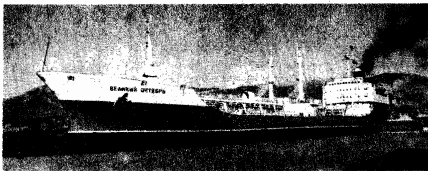
Рис. 1.14. Танкер «Великий Октябрь» грузоподъемностью 15 000 т (1967 г.)
