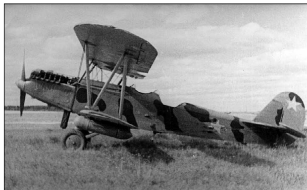
Основной разведчик ВВС КА Р-5 с подвесными грузовыми мешками
