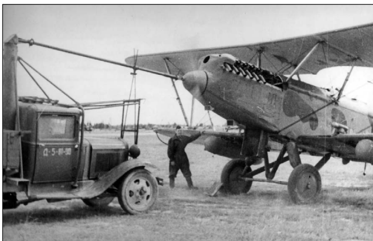
Запуск мотора Р-5 с помощью автостартера
