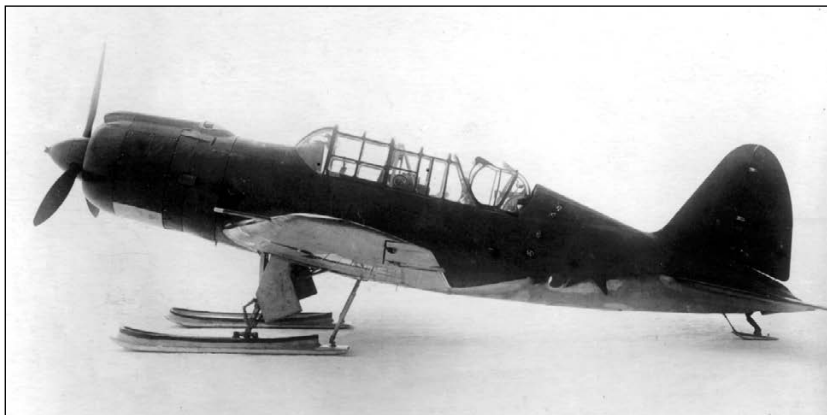
Зимой Су-2 мог эксплуатироваться на лыжном шасси
