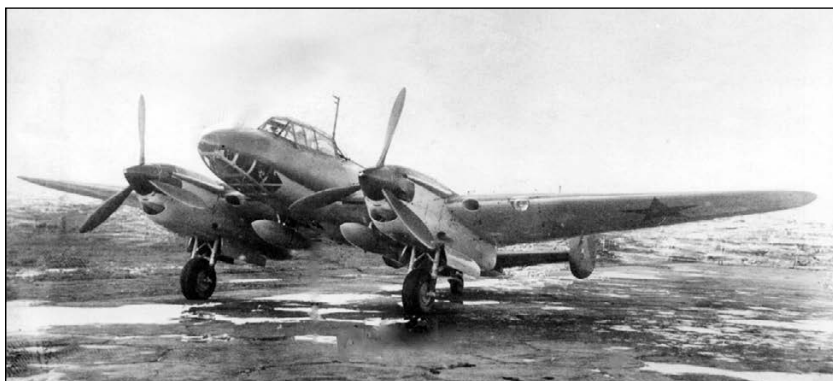
Самолет Пе-2 «И» с подвесными топливными баками
