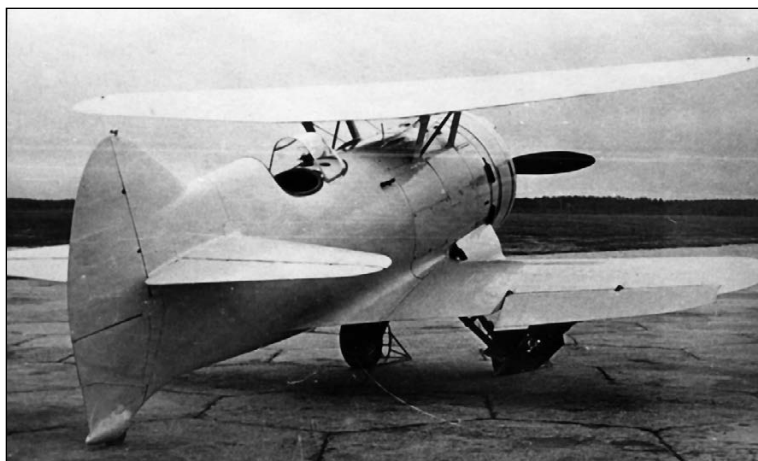
Истребитель-бомбардировщик И-207 с убираемым шасси
