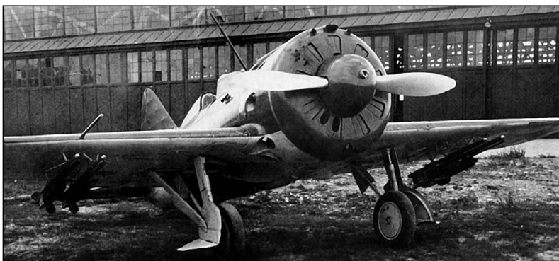
И-16 тип 29 с реактивными снарядами
