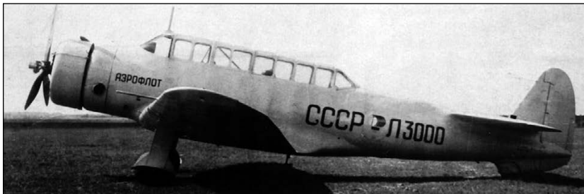
Самолет ПС-43 — конверсионный вариант штурмовика БШ-1 фирмы «Вулти»
