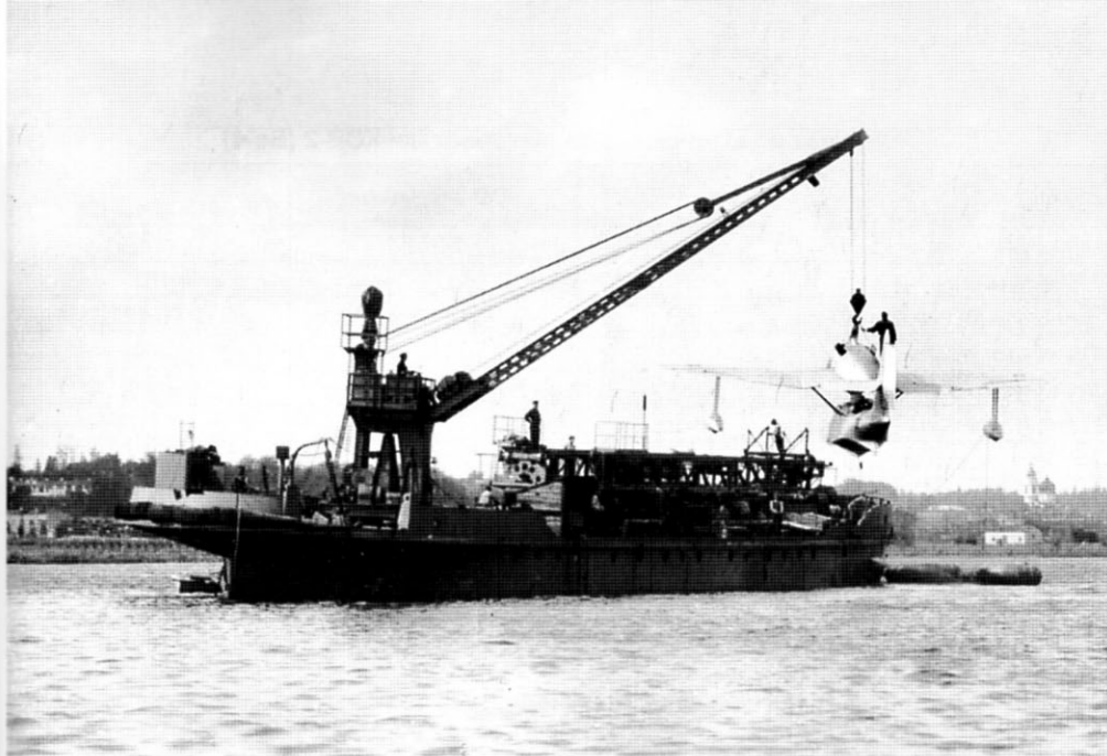
КОР-2 поднимается краном на катапульту ЗК-2Б, смонтированную на самоходной барже. Финский залив, район Ораниенбаума, август 1941 г.
