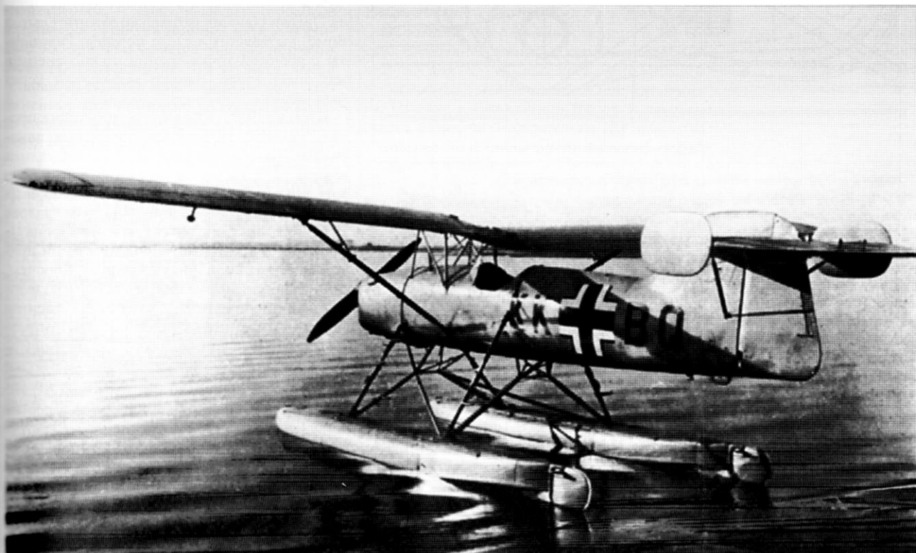
Немецкий складной самолет для подводной лодки Арадо Ar 231
